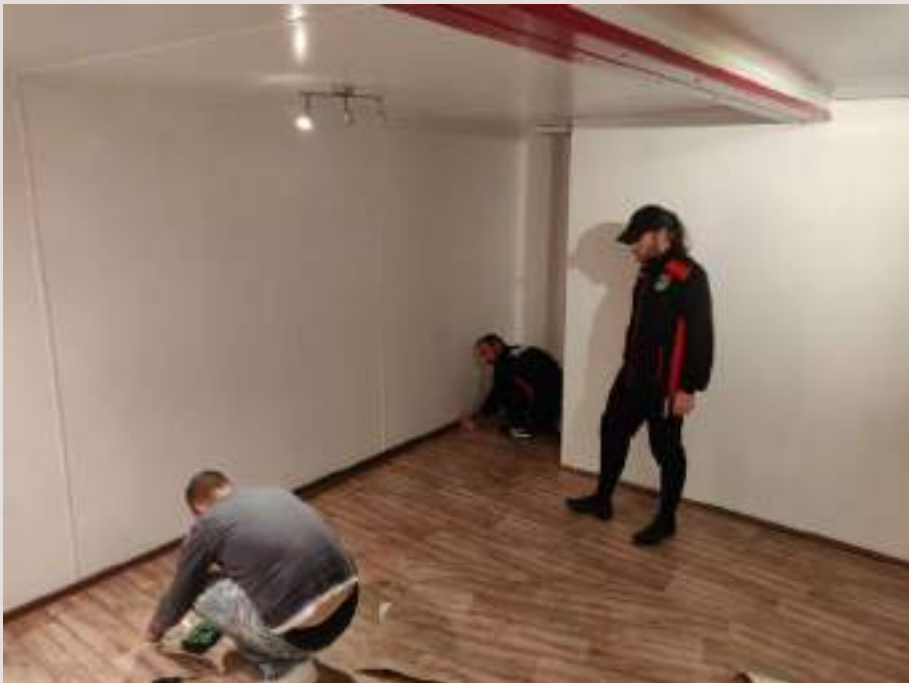
Fernando und Heiko assistieren beim Verlegen vom Boden
